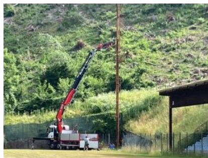
La rimozione di uno dei vecchi pali dell'illuminazione
